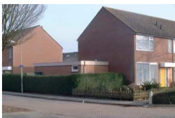
Aanbouw vormgegeven als één bouwlaag met rechthoekig plattegrond en passend materiaal en kleurgebruik.
